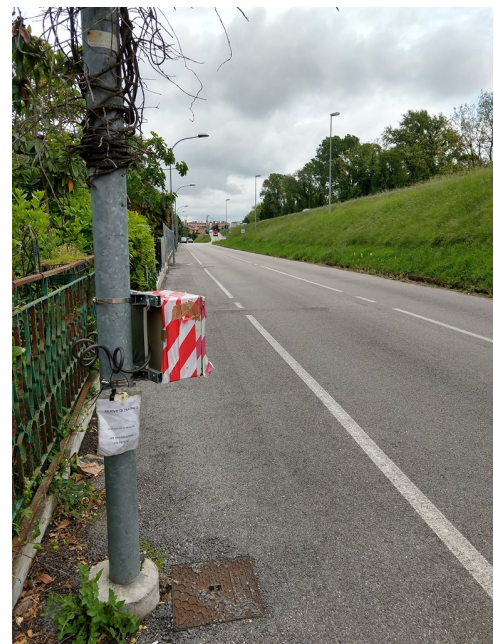
Installazione - direzione B
