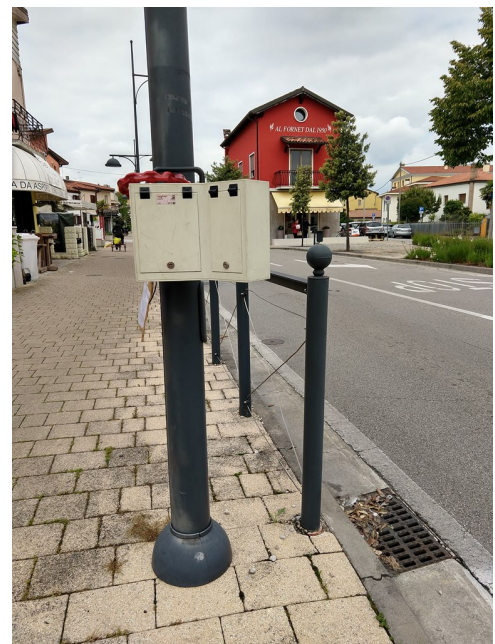
Installazione - direzione B
