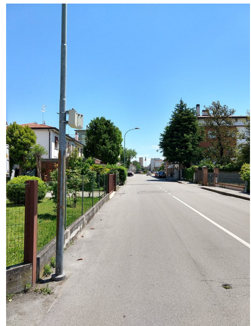
Installazione - direzione B
