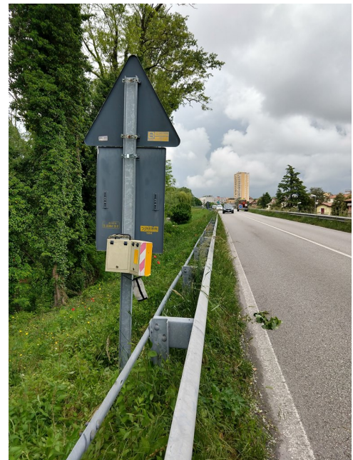
Installazione - direzione B
