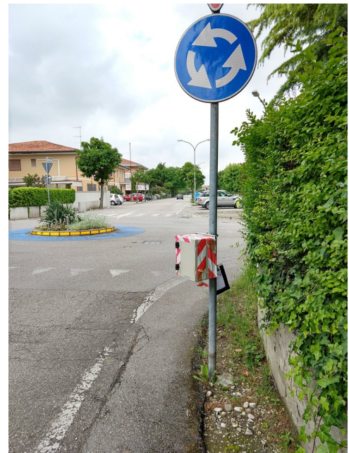
Installazione - direzione B
